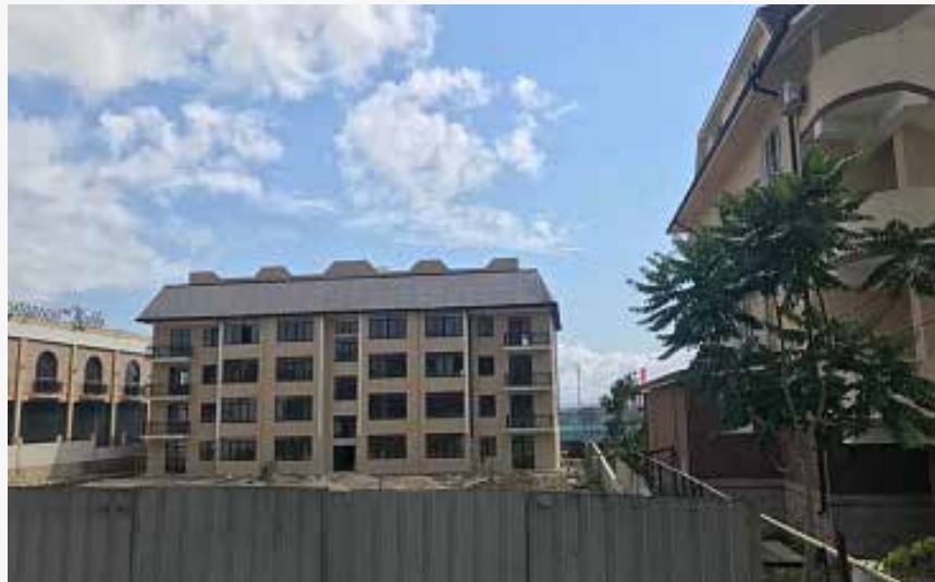
г. Сочи, Адлерский район, ул. Каспийская, 17А
