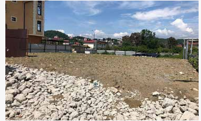
г. Сочи, Адлерский район, ул. Ружейная, 49/3
